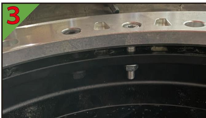
③呼びボルトで固定した状態でボルトをワッシャーとナットで仮止めしていきます。ナットがかかる程度まで仮止めしてください。
